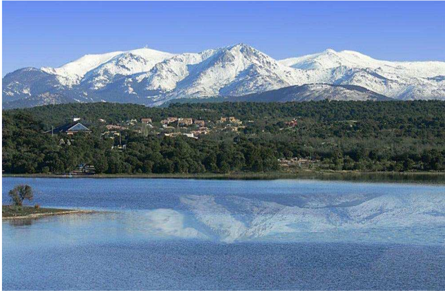
Vista de la sierra desde el viaducto de la carretera M-505. Sobre esta zona de la lámina de agua del embalse cruzaría la línea eléctrica proyectada
