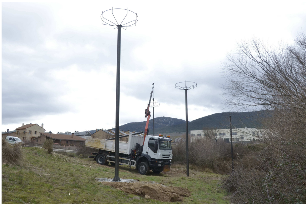
Actuaciones de obra civil, para la creación del bosque artificial como nueva ubicación para la colonia.
