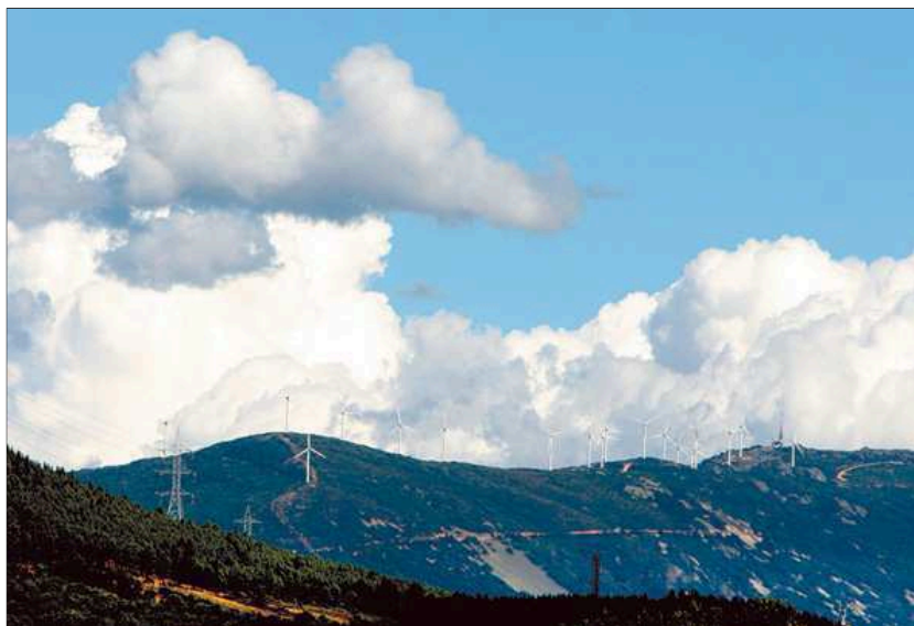
Un conjunto de nubes cubre un parque eólico. / ICAI
